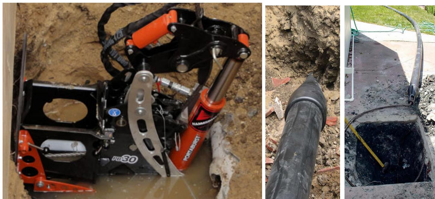
Il PortaBurst® PB30 G2 Hammerhead® è un sistema efficace, potente e robusto per il risanamento tubature.
