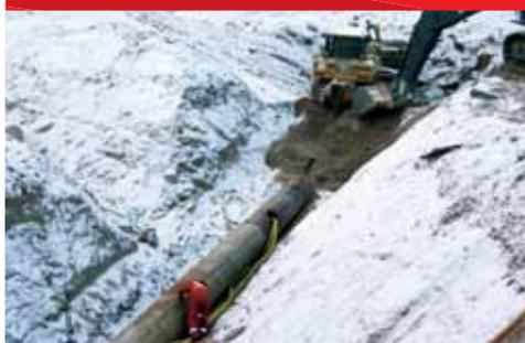
Progetto: Posa con metodo "Slick bore" di pipeline (oil)
