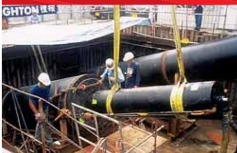
Progetto: Posa con metodo "Washover casing" in HDD Assit
