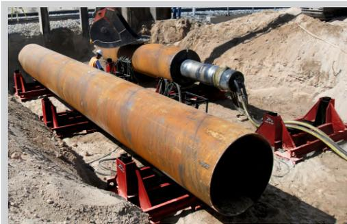
**HammerHead PIPE MULE: IL PRIMO ED UNICO SISTEMA PER IL SOLLEVAMENTO E ALLINEAMENTO TUBI NELLA POSA CON PIPE RAMMING.**
