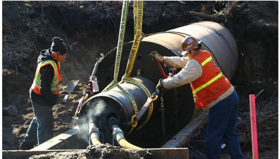
La tecnologia Pipe Ramming HammerHead è la scelta ottimale ed economicamente efficiente per la posa di tubi in acciaio sotto strade, ferrovie, e strutture, in particolare laddove l'installazione avviene in condizioni di terreno difficili come quando si è in presenza di ciottoli o di terreni sciolti.
